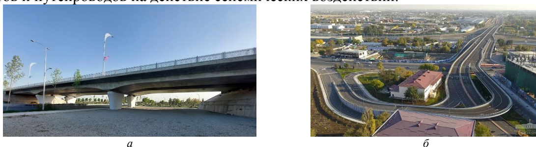
Рис. 1. Современные неразрезные (моноконтные) железобетонные путепроводы, построенные в городах Самарканд (а) и Ташкент (б)
